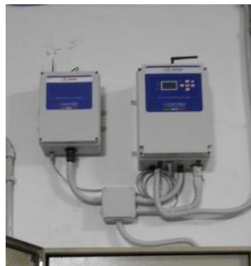
Figura 4.10 – Dispositivi per la telegestione
