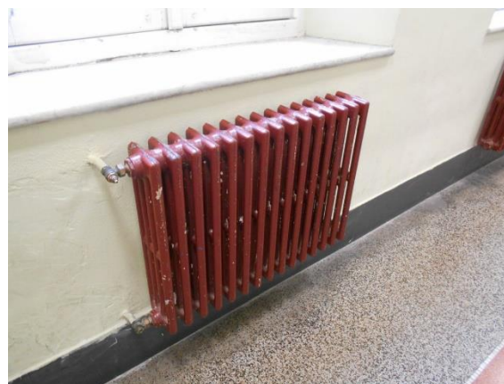
Figura 4.8 - Particolare di un radiatore in ghisa
