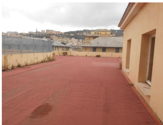
Figura 8.3 - Particolare della copertura
