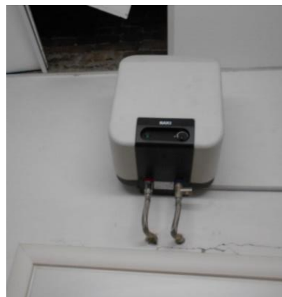
Figura 4.14 - Particolare di un boiler elettrico per la produzione di acqua calda sanitaria
