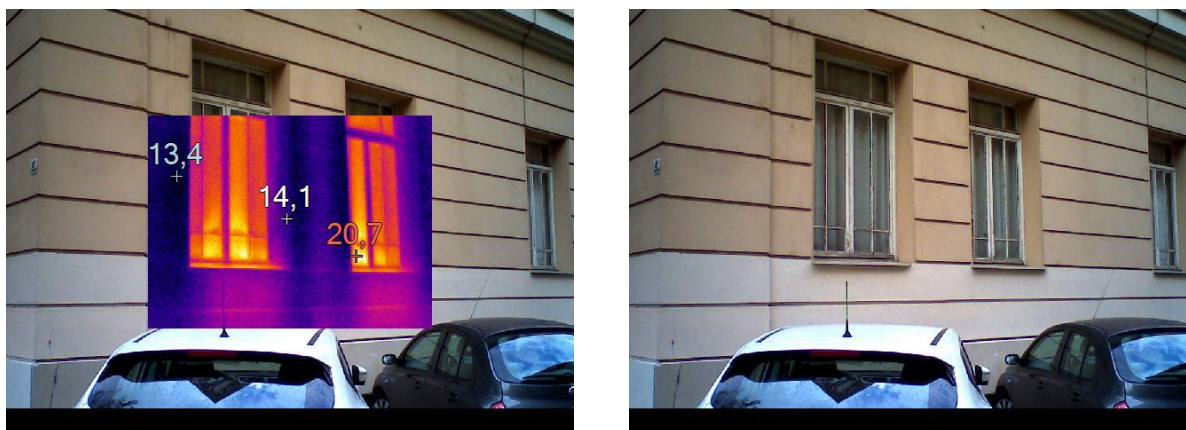
Figura 4.7 – Rilievo termografico dei serramenti
