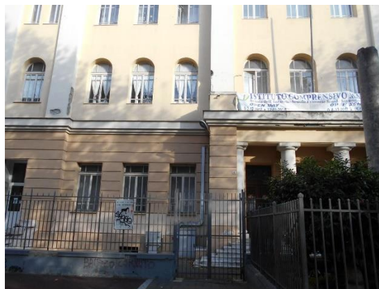
Figura 1.1 - Vista della facciata [esposta a Sud]
