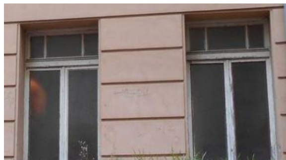
Figura 4.4 - Particolare dei serramenti – vista dall’esterno
