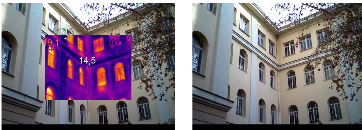
Figura 4.3 – Rilievo termografico della parete
