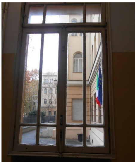
Figura 4.5 - Particolare dei serramenti – vista dall’interno
